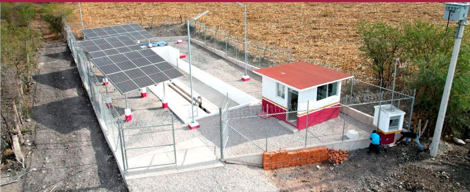
Con el fin de modernizar el Acueducto Río Colorado-Tijuana, en Baja California, e incrementar su capacidad a 6 metros cúbicos por segundo, en 2024 se concluyó la primera etapa de la actualización de sus equipos de bombeo y del sistema de control. Esta obra garantizará el suministro de agua potable a 1.8 millones de habitantes de los municipios de Tecate, Tijuana y Playas de Rosarito, con una inversión plurianual de más de mil MDP.
